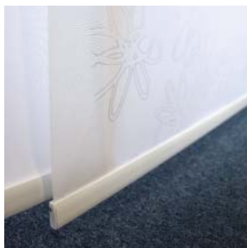
Detail spodní lišty posuvného panelu
